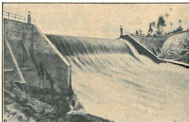
SCARICATORE DI BACINO ACCUMULATORE IN UN IMPIANTO IDROELETTRICO
